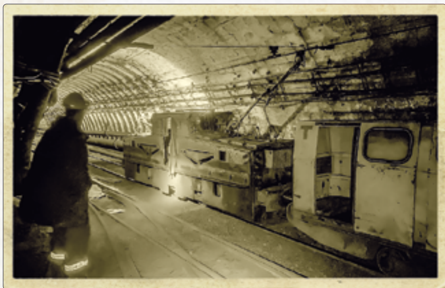
Baňa Handlová, elektrická lokomotíva
