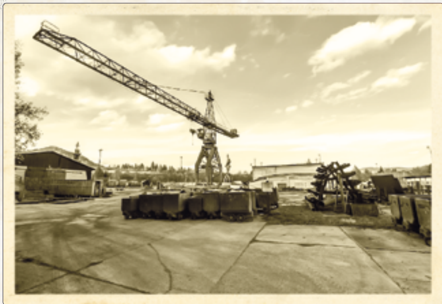
Portálový žeriav na bani Handlová
